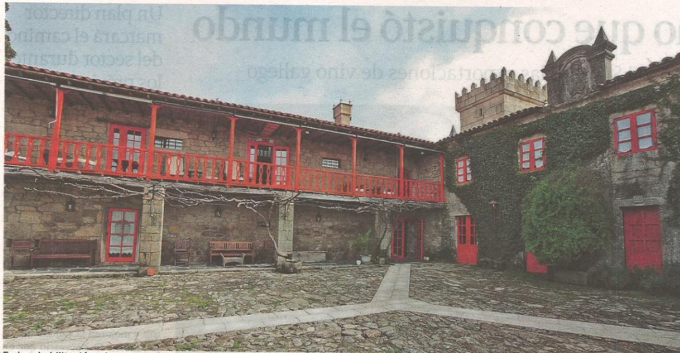
En la rehabilitación y la reconstrucción de la Casa Grande de Rosende se ha mantenido la esencia del edificio. M. MARRAS
